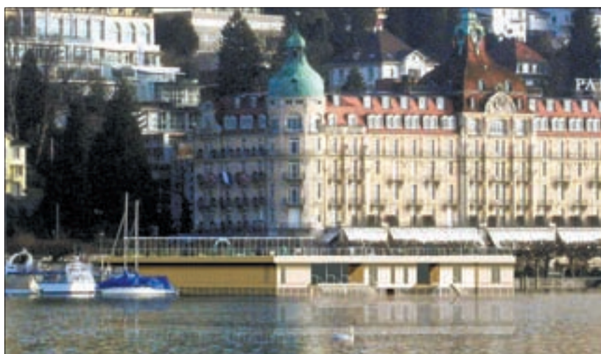
So könnte die Seebadi nach der Sanierung aussehen.
